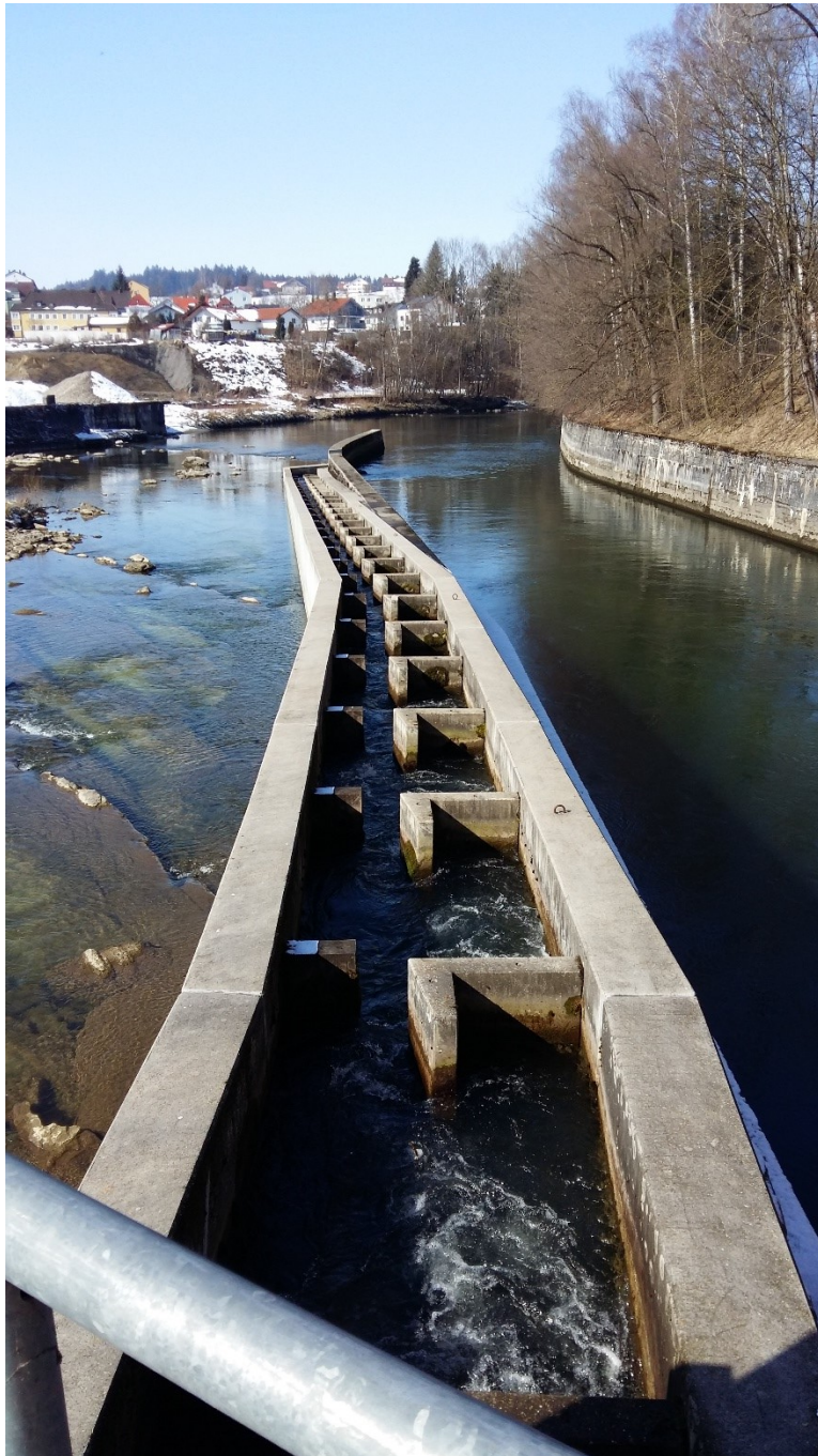
Foto 3: Ansicht Fischtreppe von Krafthaus aus
