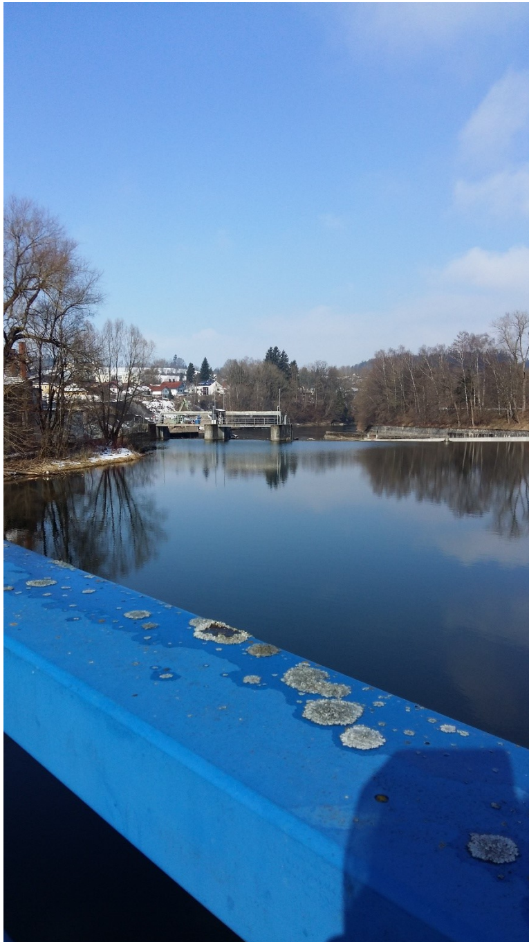
Foto 2: Ansicht Wehrfeldverschluss 2 & 3 von Fußgängerbrücke aus
